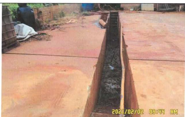
Foto 04: Área do lavador saturada com sedimentos.
