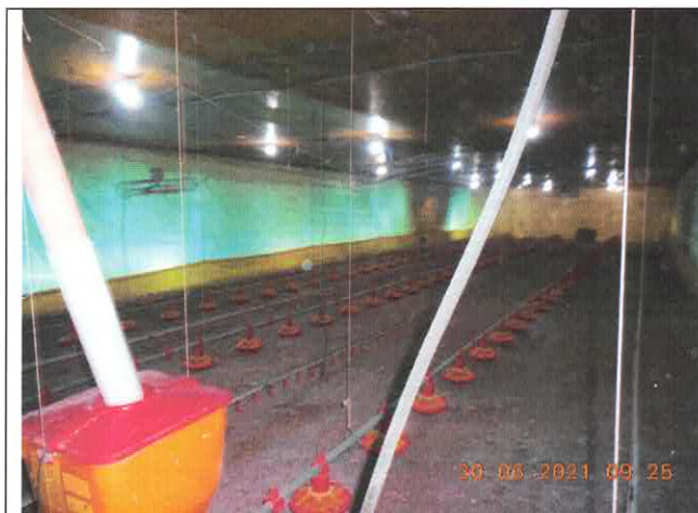
Figura 1: Área interna do galpão.
