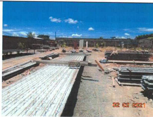
Figura 2: Área de fabricação da lajes.
