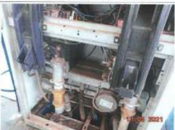
Figura 6: Espaçamento sump/parede da bomba.
