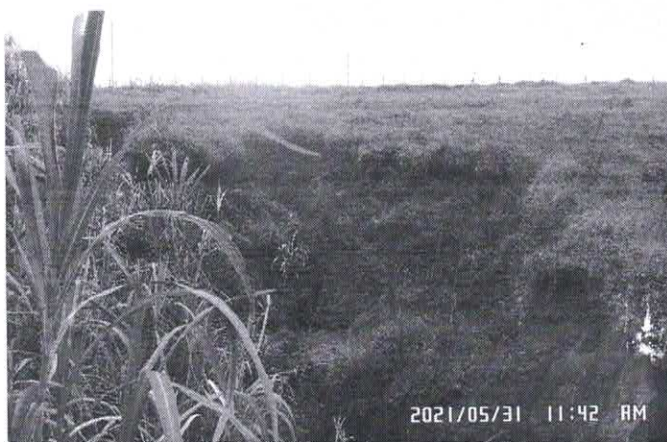
Figura 3: Processo Erosivo a jusante do empreendimento
