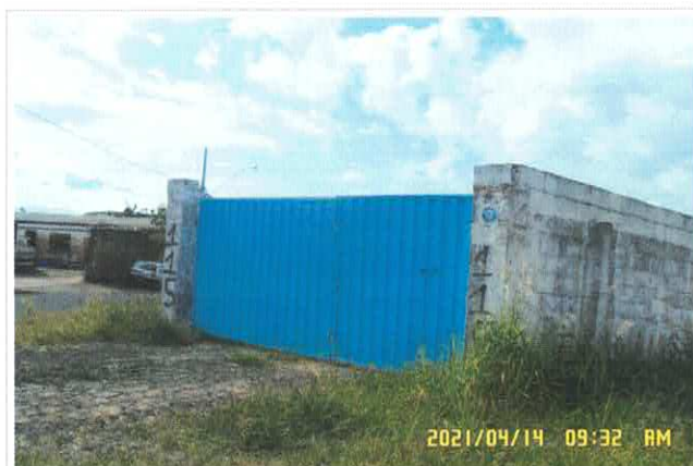
Figura 1: Vista da entrada do empreendimento
