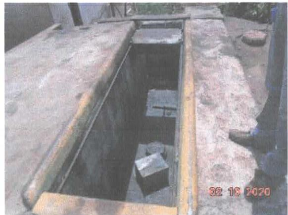
Figura 4: Vala de lubrificação em área externa.
