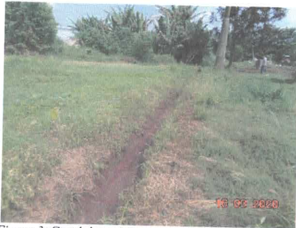
Figura 3: Canal de escoamento de água pluvial.
