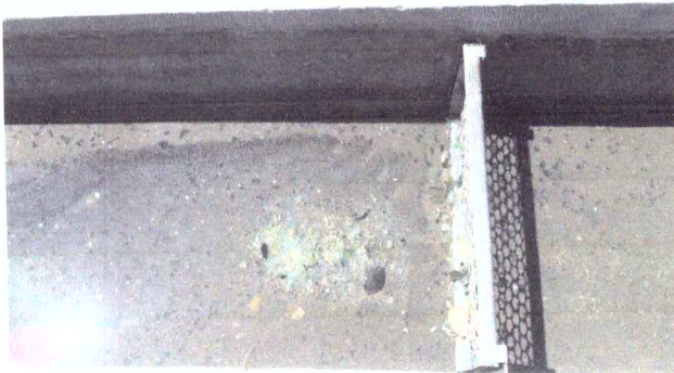
Figura 1: gradeamento no pré-tratamento
