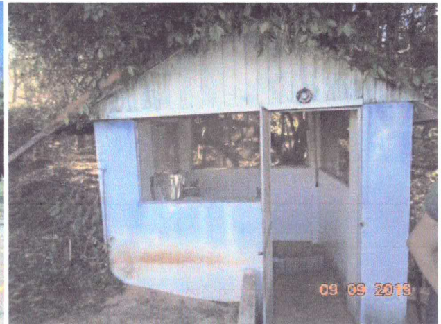
Figura 2: Local da captação em surgência
