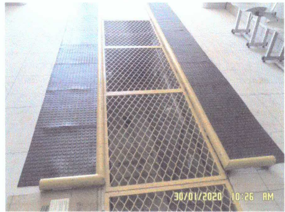
Figura 2: Área de troca de óleo.
