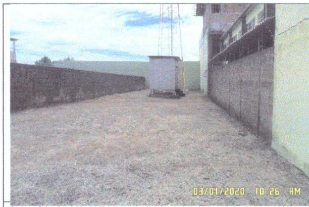
Foto 01: Local em bom estado de conservação
