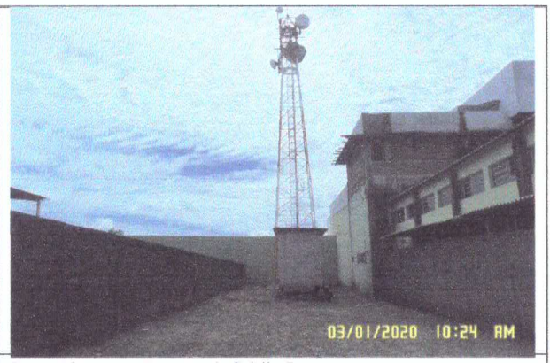
Foto 02: Estação de Rádio Base
