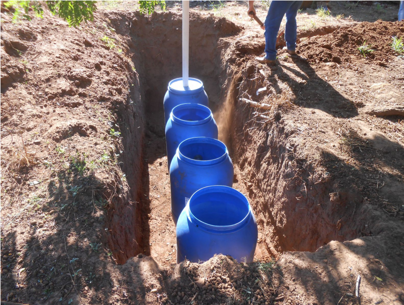
Figura 08: Fossas com filtros biológicos
