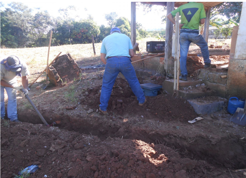
Figura 09: Construção de fossas na comunidade Mercês
