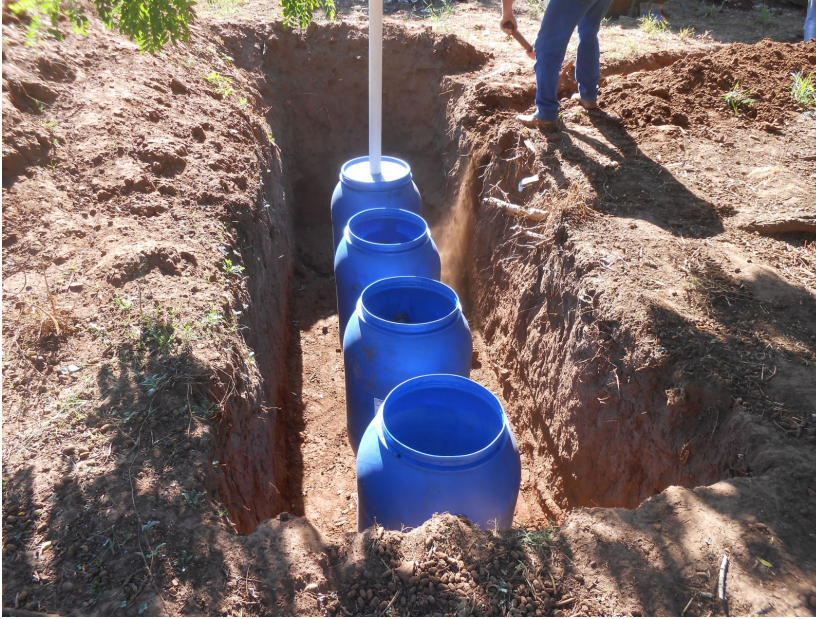
Figura 09: Fossas com filtros biológicos
