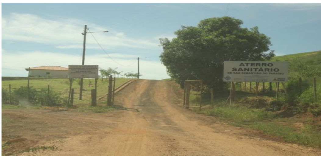
Figura 05: Aterro Sanitário Municipal
