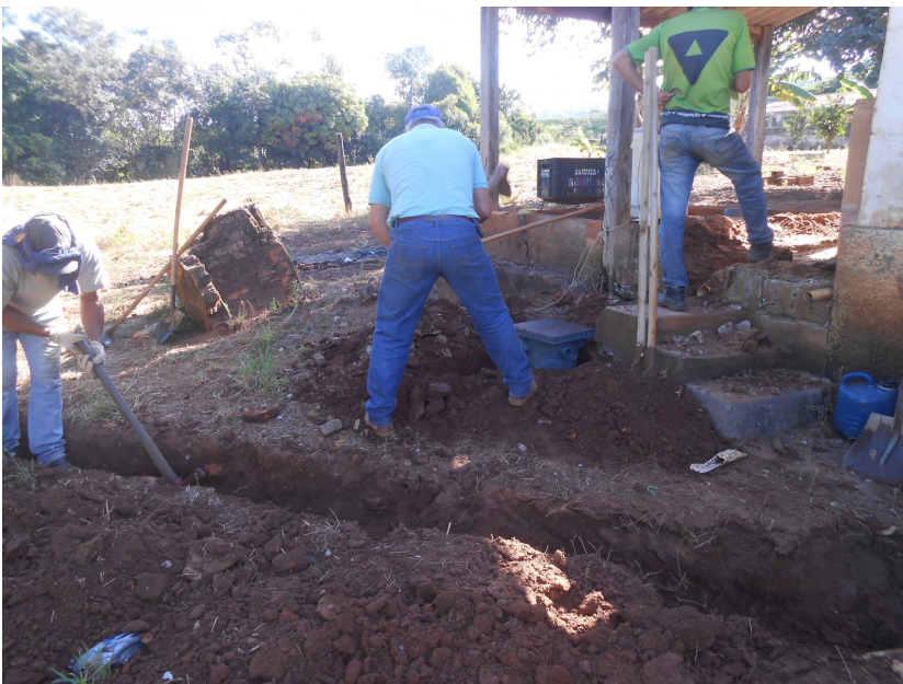
Figura 10: Construção de fossas na comunidade Mercês
