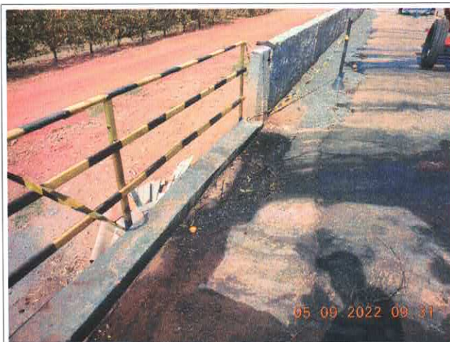
Foto 01: Efluente contaminado proveniente do lavador.
